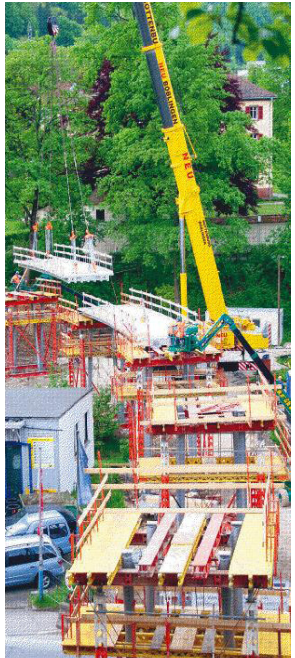
Passgenau: Ein Autokran zieht die tonnenschweren Brückenteile nach oben und senkt sie an der richtigen Stelle millimetergenau auf die Stützen ab. Foto: stu
