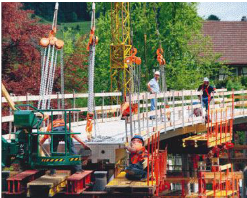
Lautlinger Textilbetonbrücke nimmt Formen an: Stück um Stück werden die Oberflächenteile eingepasst. Foto: stu
