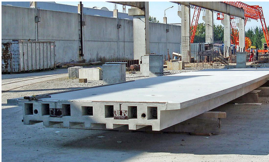
Das erste, 17,2 Meter lange Brückenelement für die Textilbetonbrücke in Lautlingen ist fertig.
